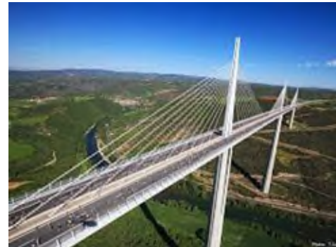
Viaduc de Millau
