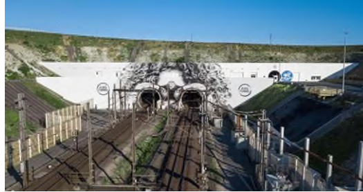
Tunnel sous la Manche
